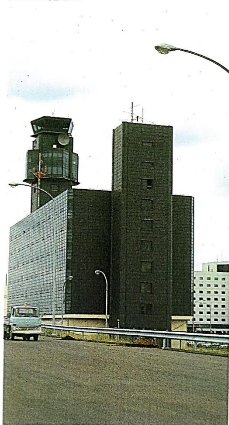
完成した空港管理ビル
